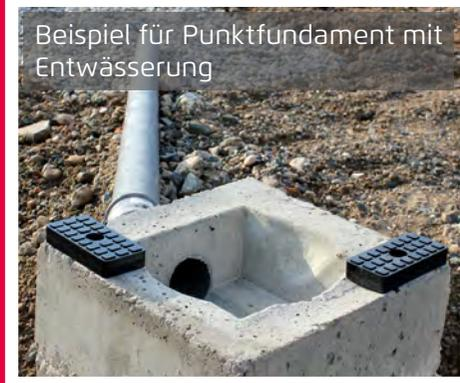
Beispiel für Punktfundament mit Entwässerung
