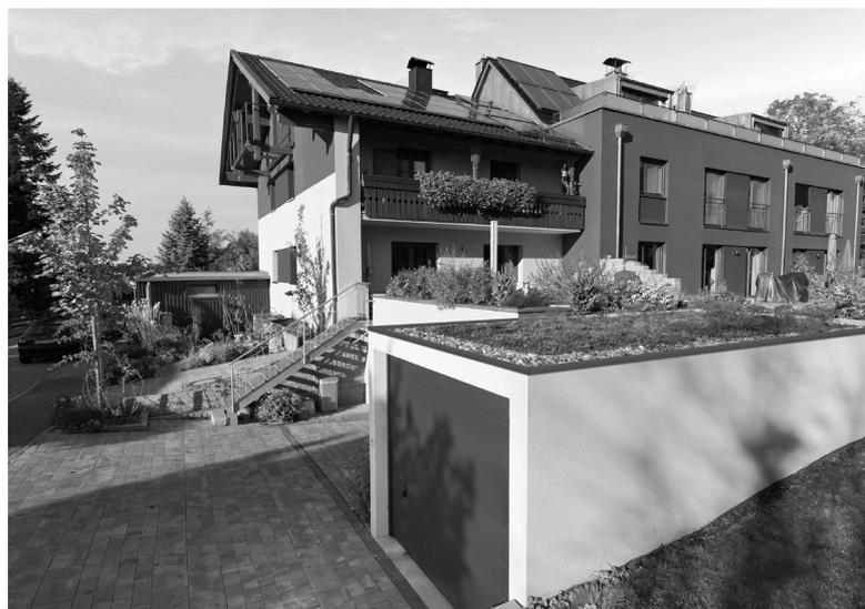
Bei schrägem Geländelauf können Garagen mit verstärkten Wänden und Dach in den Hang eingebaut werden. Ebenso ist eine vollständige An- oder Überschüttung bei besonderen Bauteilausführungen möglich. Dies setzt einen tragfähigen Untergrund gemäß den einzelnen Fundamentplänen und bei Baugruben standsichere Böschungen voraus.
