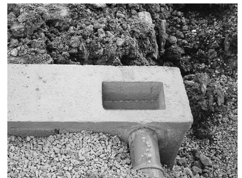
Fundament unter der Garagenrückwand mit Aussparung und Ablaufrohr (hier nach vorne weggeführt)
